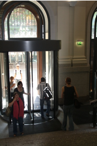
Entscheidender Effekt: Die neue Karusselltür in der Bibliotheca Albertina trennt die Luftschichten und erlaubt, die Außentür sommers wie winters einladend offen zu halten.
